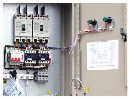
Участнику, в отведенное время, необходимо произвести монтаж схемы автоматического включения резервного питания выключателя (ABP) с соблюдением требований по безопасности согласно принципиальной схеме с учетом селективности, нагрузки и сечения проводников. Напряжение на ЭЩ не подается, корректность проверяется визуально и путем прозвонки. Произвести выбор необходимых материалов и инструментов.
